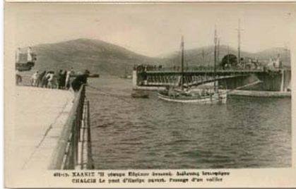
0289 - ΧΑΛΚΙΔΑ. Η Γέφυρα του Ευρίπου ανοικτή με διέλευση ατμοπλοίου και η Γέφυρα του Ευρίπου ανοίγουσα, δύο κάρτες (Δέλτα 401-17 & 400-16). - 12
