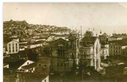
0576 - ΚΑΒΑΛΑ. Μερική άποψη, εργασίες επισκευών στον Ναό του Αποστ. Παύλου, ασπρ/ρη. - 10
