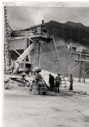
1557 - Σκυροθραυστικό μηχανήμα στις ασφαλτοστρώσεις δρόμων της Πελοποννήσου, φωτο διαστ. 13 x 18. - 8
