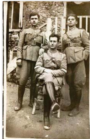
1541 - ΜΕΣΣΗΝΙΑ. Σταθμός Χωροφυλακής Κοροφασίου, φωτο του 1931, διαστ. 8,5 x 13,8. - 8
