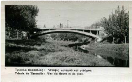
0349 - ΤΡΙΚΑΛΑ. Η Γέφυρα του Ληθαίου, ασπρ/ρη, γραμμένη το 1960. - 9
