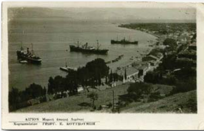
0178 - ΑΙΓΙΟ. Μερική άποψις Λιμένος, ασπρ/ρη (Γ. Κουτσουμπή). - 9
