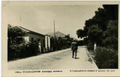
0126 - ΞΥΛΟΚΑΣΤΡΟ. Λεωφόρος πευκίωνος, ασπρ/ρη (Δέλτα 1525-4). - 8
