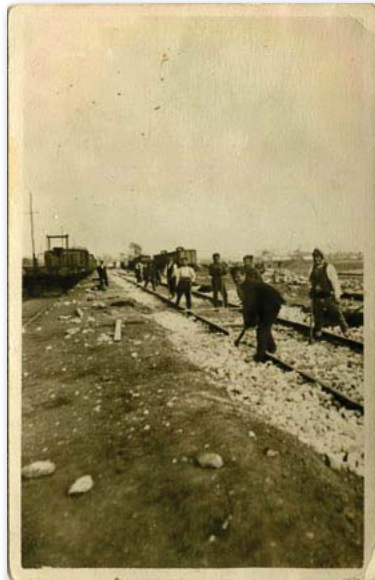
0556 - ΔΡΑΜΑ. Εργασίες στον σιδηροδρομικό σταθμό, φωτοκάρτα του 1925. - 15
