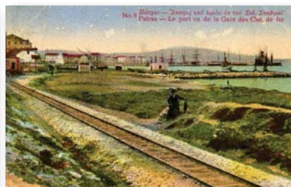
0202 - ΠΑΤΡΑ. Άποψις του Λιμένος εκ του Σιδηροδρομικού Σταθμού, έγχρωμη (Ν. Κατσαντώνη). - 13
