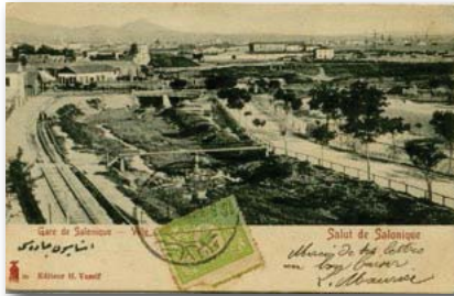
0495 - Περιοχή Σιδηροδρομικού Σταθμού, ασπρ/ρη (Vassif 38), ταχυδρομημένη το 1904. - 10
