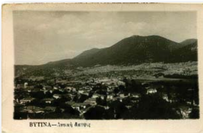
0134 - ΒΥΤΙΝΑ. Δυτική άποψη, ασπρ/ρη. - 8
