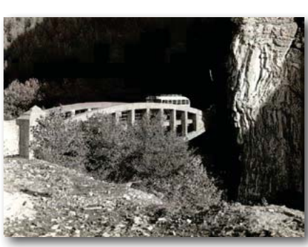
1742 - ΠΥΛΗ Τρικάλων, η γέφυρα κατασκευασθείσα το 1930, φωτο διαστ. 23 x 16,5. - 8
