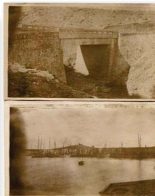
1533 - ΛΑΥΡΙΟ. Αποβάθρα φορτοεκφορτώσεων των Μεταλλουργείων και οδογέφυρα στην θέση Αδάμ-Πλάκα, που ανατινάχθηκαν από τους Γερμανούς το 1944, δύο φωτο, διαστ. 13,5 x 8,5. - 9
