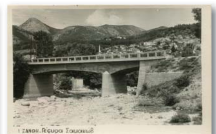
7619 - ΞΑΝΘΗ. Γέφυρα Σαμακώβ, ασπρόμαυρη Νο 1 του 1956. - 13
