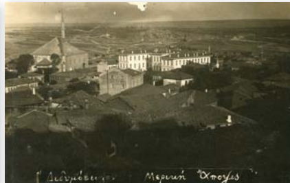
7671 - ΔΙΔΥΜΟΤΕΙΧΟ. Μερική άποψη, ασπρόμαυρη. - 15
