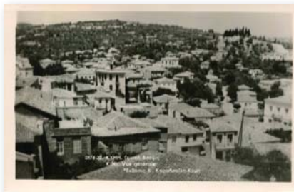
7322 - ΚΥΜΗ. Γενική άποψη, ασπρόμαυρη (Δέλτα 876-22). - 12
