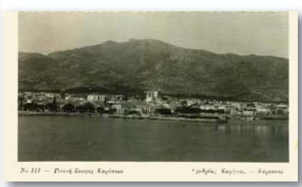
7320 - ΚΑΡΥΣΤΟΣ. Γενική άποψη, ασπρόμαυρη (Ανδρέας Καρίγκας 111). - 12
