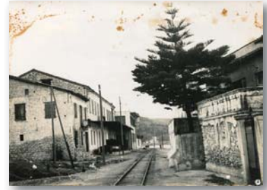
9287 - ΑΙΓΙΟ. Περιοχή εργοστασίων, φωτο Κουρμπέτη διαστ. 18 x 13. Ελαφρές οξειδώσεις άνω. - 13
