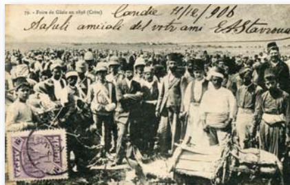
7811 - Εμποροπανήγυρη στο Γάζι Ηρακλείου, ασπρόμαυρη (Behaeddin 79), ταχυδρομημένη το 1906. - 30
