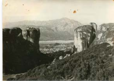
9292 - ΜΕΤΕΩΡΑ. Αποψη των βράχων των Μετεώρων στο βάθος η Καλαμπάκα, φωτο διαστ. 18 x 13. - 12
