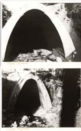
9414 - ΑΘΗΝΑ. Τιμμεντοποίηση και υπογειοποίηση των ρεμάτων Ηριδανού, Ζωγράφου και οδού Μυκάλης συμβολή με Ποδονίφτη, τρεις φωτο διαστ. 24 x 18 εκάστη. - 15
