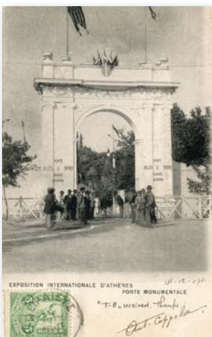
7036 - Διεθνής Έκθεση Αθηνών 1903, η Πύλη εισόδου και εκδοτήριο εισιτηρίων, ασπρόμαυρη (P & C), ταχυδρομημένη το 1904. - 25
