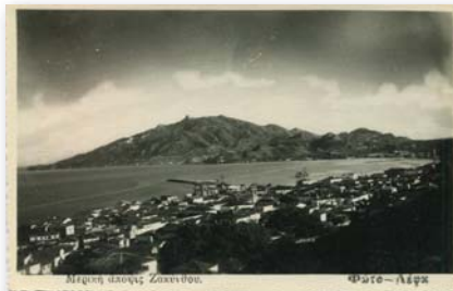
7199 - ΖΑΚΥΝΘΟΣ. Μερική άποψη, ασπρόμαυρη (Φωτο Λέφα). - 13
