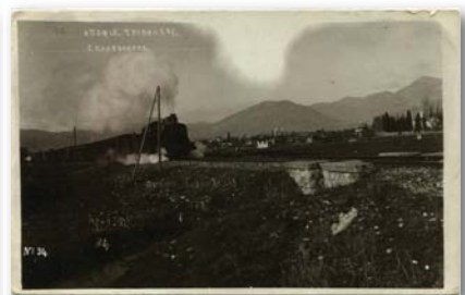
7112 - ΤΡΙΠΟΛΗ. Άποψη με διερχόμενο τρένο, ασπρόμαυρη (Γ. Κομποχόλης). - 15
