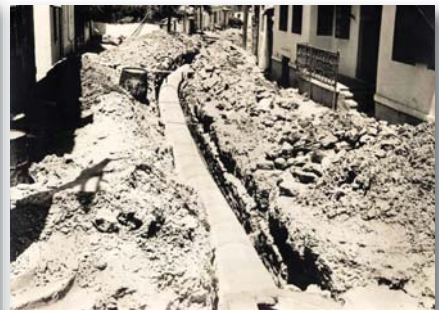
9445 - ΔΙΔΥΜΟΤΕΙΧΟ. Κατασκευή των υπονόμων της πόλης, φωτο διαστ. 30 x 21,5. - 13
