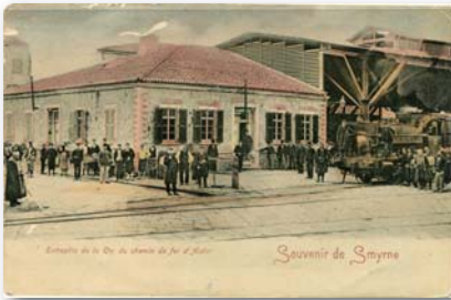
7903 - ΣΜΥΡΝΗ. Οι αποθήκες του Σιδηροδρόμου Αϊδινίου απέναντι του Τελωνείου, έγχρωμη. Μικροεκδορές άνω αριστερά. - 18
