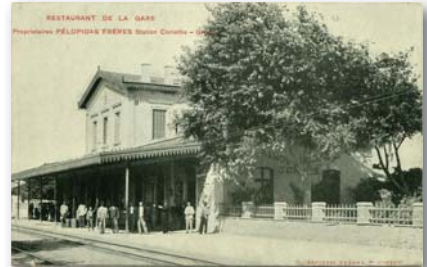
7103 - ΚΟΡΙΝΘΟΣ. Ο σιδηροδρομικός σταθμός και το ρεστοράν ιδιοκτ. Αφών Πελοπίδα, ασπρόμαυρη (Ασπιώτης). - 15
