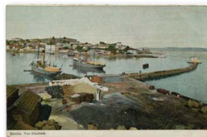
7703 - ΜΥΤΙΛΗΝΗ. Γενική άποψις λιμένος, έγχρωμη. - 13
