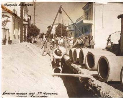
9443 - ΑΜΥΝΤΑΙΟ. Κατασκευή υπονόμων οδού 5ης Μεραρχίας, φωτο διαστ. 29,5 x 23,5. - 14
