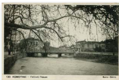
7653 - ΚΟΜΟΤΙΝΗ. Γαλλική Γέφυρα, ασπρόμαυρη (Φωτο Βάττη 130). - 12
