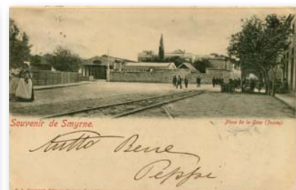
7901 - ΣΜΥΡΝΗ. Πλατεία του Σταθμού της Πούντας, ασπρόμαυρη (P. Demond), ταχυδρομημένη το 1902. - 25
