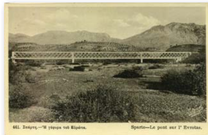
7132 - ΣΠΑΡΤΗ. Η Γέφυρα του Ευρώτα, καφεκίτρινη (Nicourt 441). - 14
